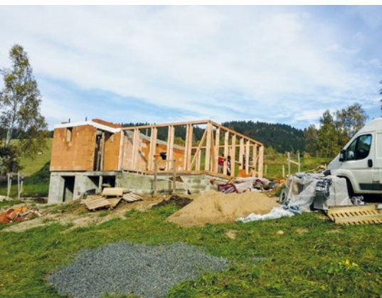
Část domu je postavena z cihelných termobloků, které dodávají objektu větší tuhost a mají lepší akumulaci vlastností.
