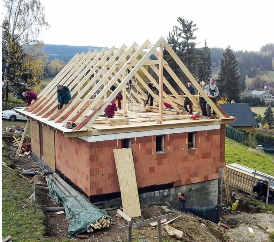
Druhá polovina přízemí a patro je dřevostavba postavená ze sušeného hranolu a obložená z venkovní i vnitřní strany masivní palubkou.
