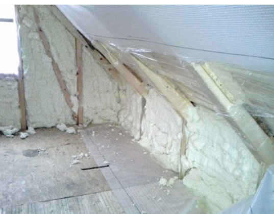
Zateplit celý dům stříkanou pěnou trvalo pouhé dva dny.
