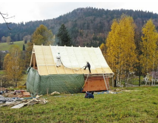
K izolaci střechy nad krokvemi byla zvolena uzavřená stříkaná polyuretanová pěna, která má výborné tepelné i hydroizolační vlastnosti.
