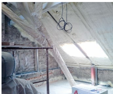
K zateplení šikmín použila stavební firma stříkanou pěnu.
